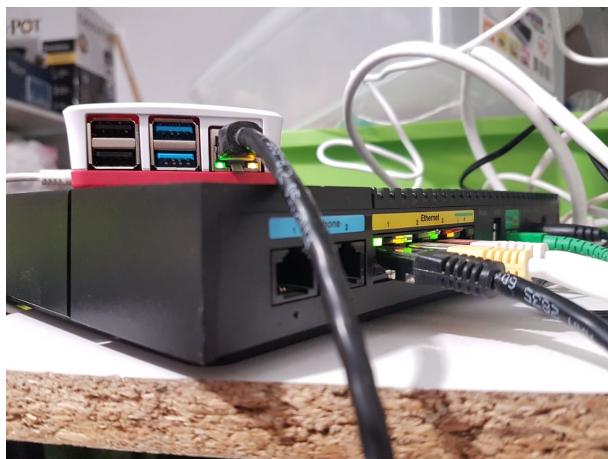
Connexion au réseau local
